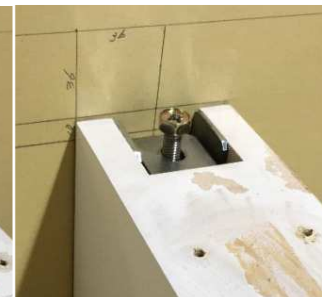
③ 壁面側金具へササrah側金具を引掛け、連結ボルトで固定
