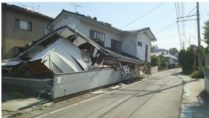
倒壊建物の状況__在来仕口(羽子板金物)の柱・梁接合部は激しく破壊
