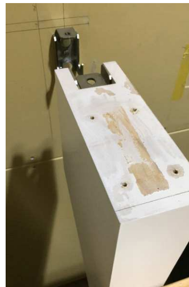
③ 壁面側金具へササrah側金具を引掛け、連結ボルトで固定
