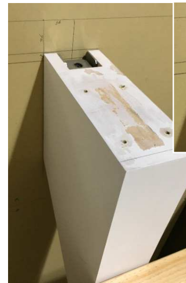
③ 壁面側金具へササrah側金具を引掛け、連結ボルトで固定
